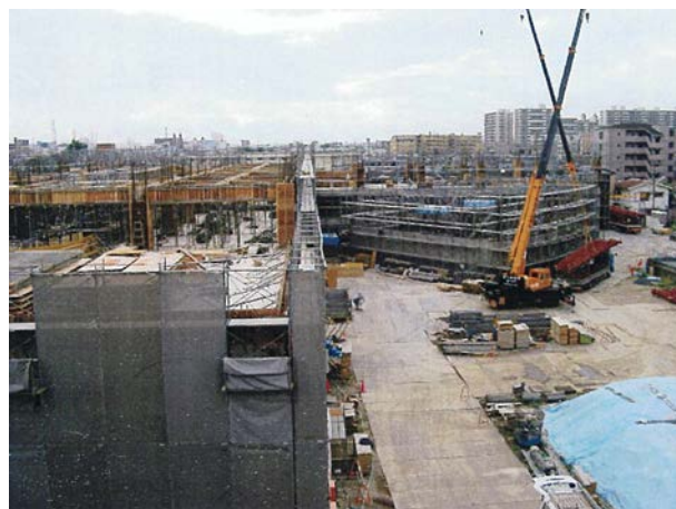
第 4 図 川崎高校新校舎建設工事風景 （平成 16 年 8 月 4 日） （川崎高校「新校舎建設のあゆみ」より）
